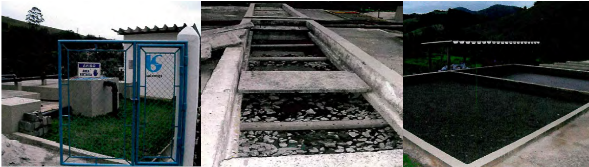
Figura 64: ETE Monteiro Lobato, na sequência, vistas da entrada, filtro anaeróbio e leito de secagem.
