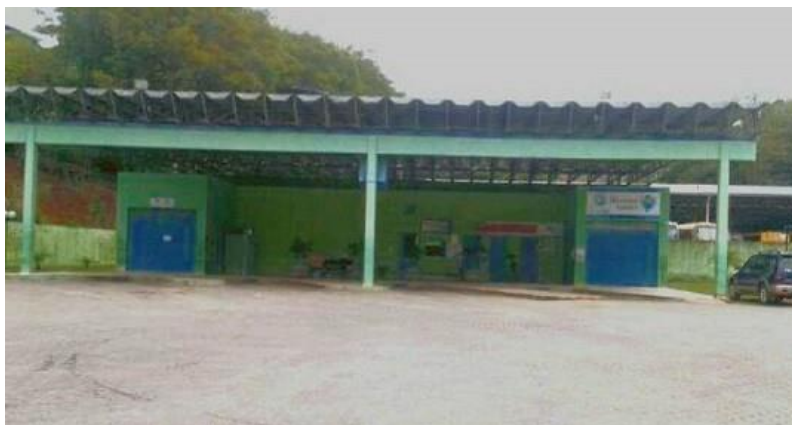
Figura 104: Terminal Rodoviário do Município de Monteiro Lobato.
