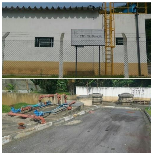
Figura 81: ETE e Elevatório em São benedito.
