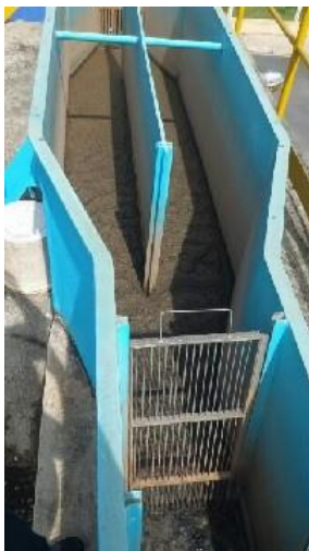
Figura 82: Sistema de gradeamento seguido de desarenador.
