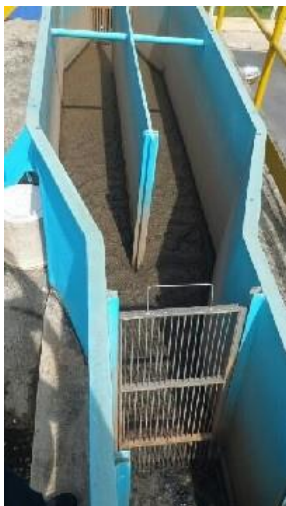
Figura 82: Sistema de gradeamento seguido de desarenador.
