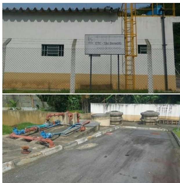
Figura 81: ETE e Elevatório em São benedito.
