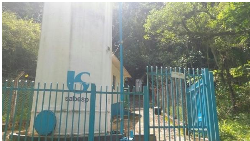
Figura 78: Reservatório de Água do bairro São Benedito.
