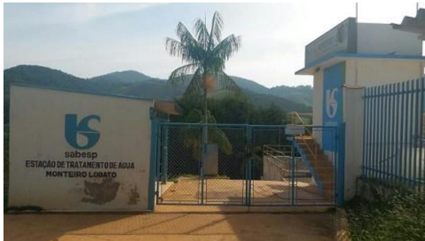
Figura 77: Sistema Sede - Estação de Tratamento de Água de Monteiro Lobado.
