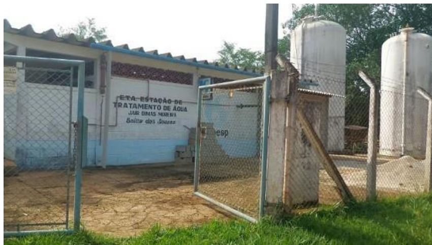
Figura 79: ETA Jair Dimas Moreira - Bairro do Souza.
