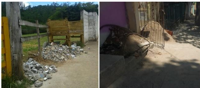
Figura 99: RCC disposto na calçada para coleta.
