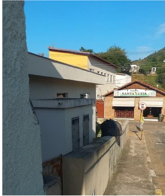
Figura 94: Local de armazenamento de resíduos sólidos comuns e recicláveis até o momento da coleta.
